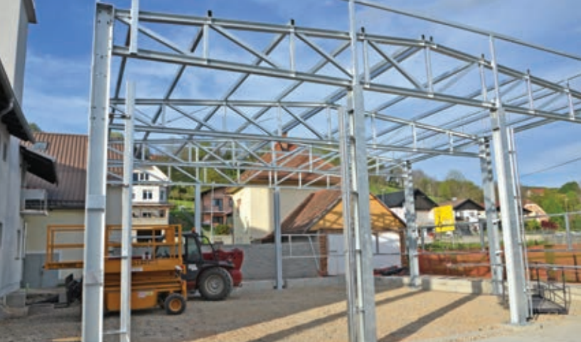
Vmesna faza gradnje
