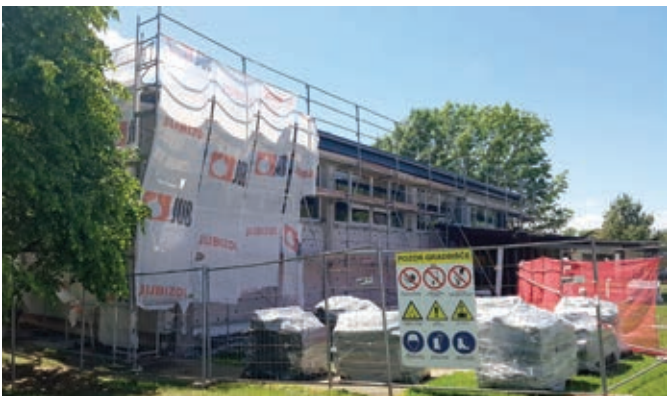
Telovadnica OŠ Duplek: zamenjana streha, vgrajena nova okna, nameščen toplotni ovoj
