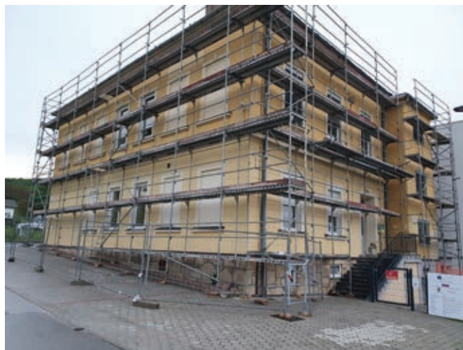
OŠ Žitečka vas, pripravljena za zamenjavo strehe in obnovo fasade Foto: Natalija Jakopec
